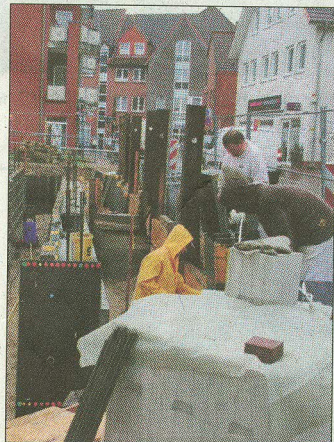
Hier wurde noch das Fundament für das Näh-Atelier errichtet.
