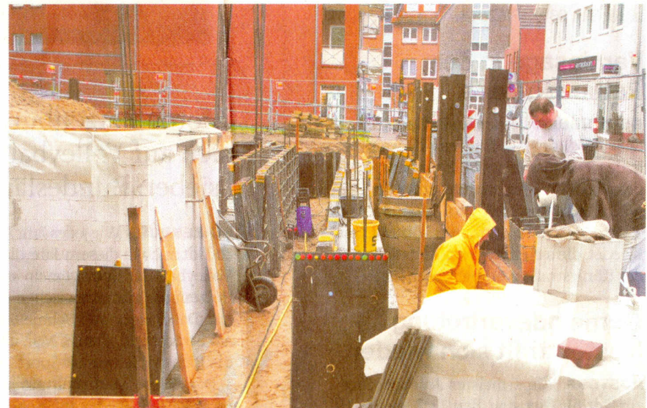
Handwerker errichten in der Sandstraße das Fundament für den Neubau der Schneiderei.
